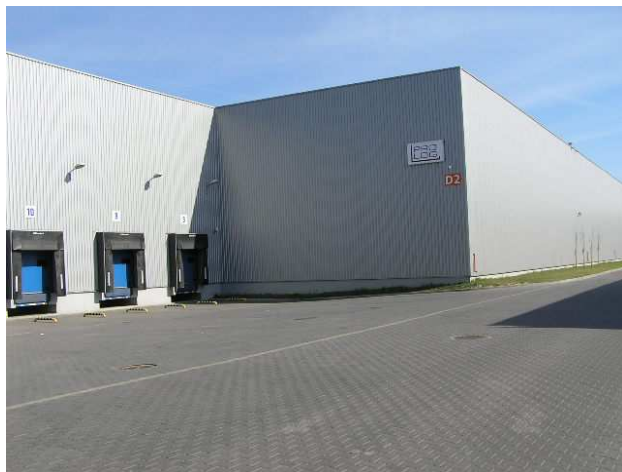
* Magazyn Emitenta - na zdjęciu widoczne są hydrauliczne doki przeładownicze
